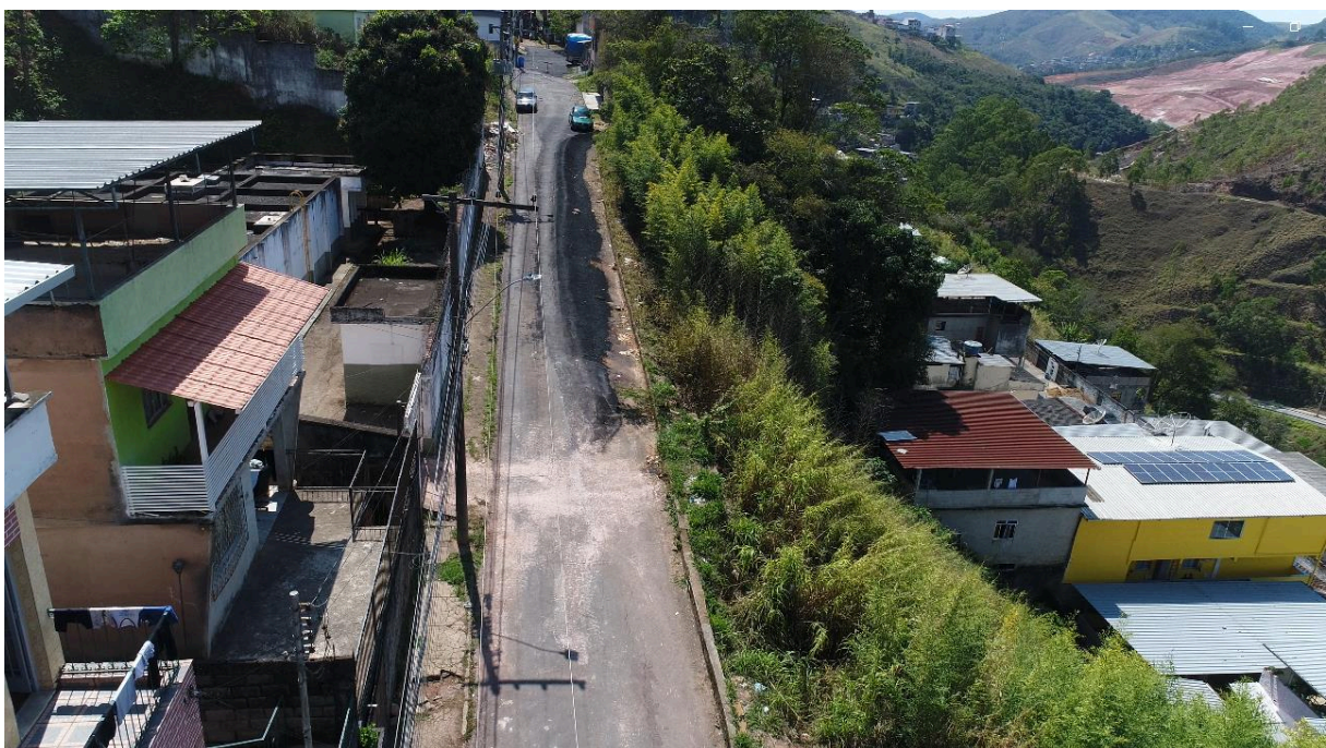
Foto 3 - Vista aérea da Rua Antônio Alves Teixeira, com a leira de saco de solo e material asfáltico interditando meia pista.
