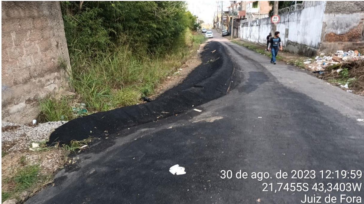
Foto 6 - Leira de saco de solo e material asfáltico implantado na Rua Antônio Alves Teixeira.
