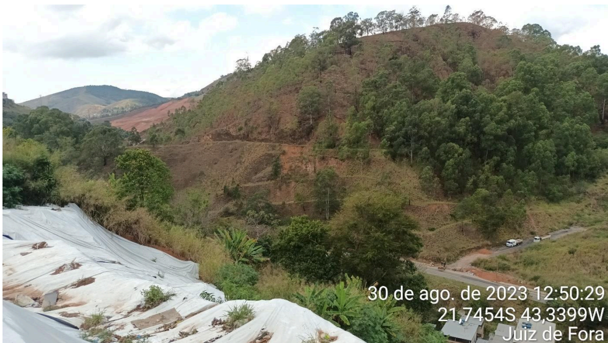
Foto 27 - Escorregamento em encosta nas adjacências do Reservatório Grajaú.
