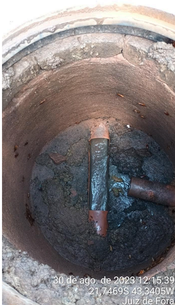
Foto 15 - PV's das tubulações de esgoto e de fornecimento de água da Rua Antônio Alves Teixeira.
