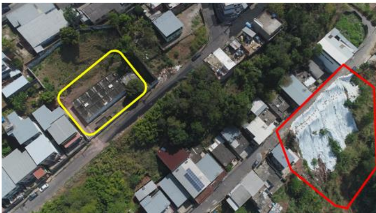
Foto 25 - Vista aérea mostrando a proximidade entre o Reservatório Grajaú (indicado em amarelo) e o escorregamento conchoidal de grande magnitude da Rua Rosa Sffeir (indicado em vermelho).
