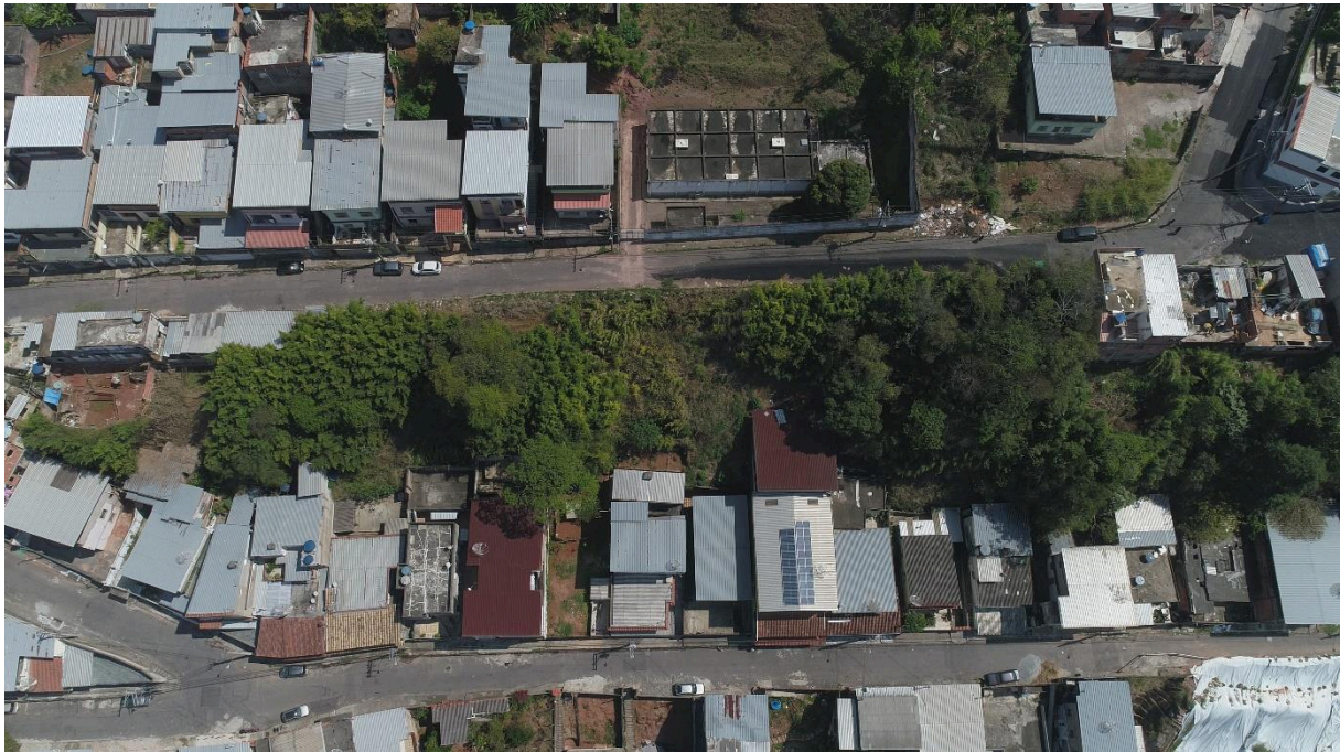
Foto 2 - Vista aérea do reservatório e da Rua Antônio Alves Teixeira.
