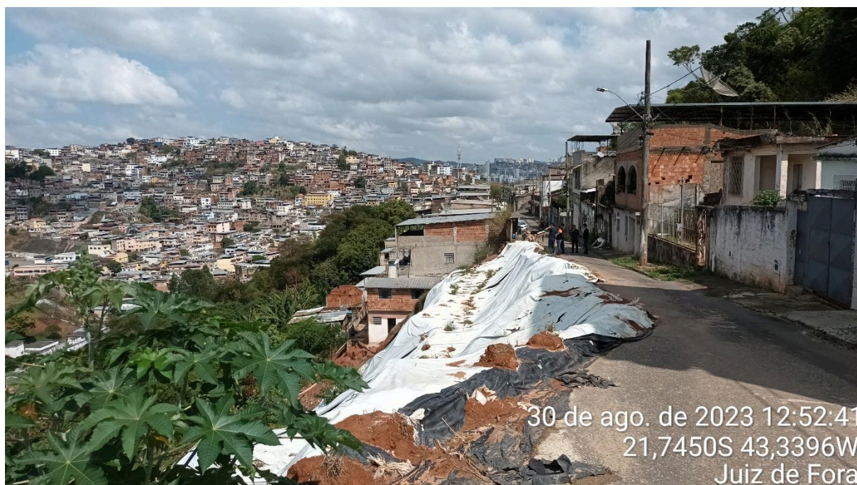
Foto 23 - Escorregamento conchoidal de grande magnitude localizado na Rua Rosa Sffeir.
