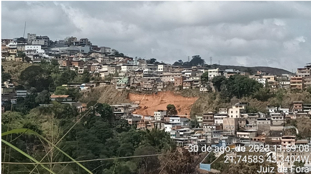
Foto 26 - Escorregamento em encosta nas adjacências do Reservatório Grajaú.
