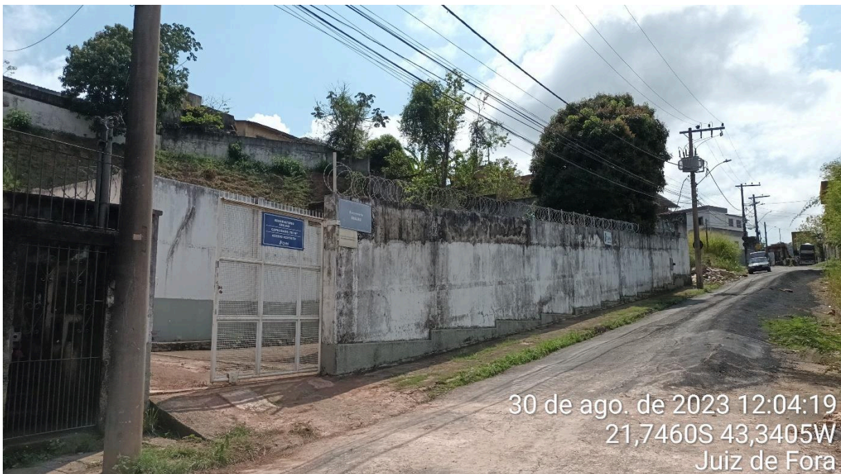
Foto 5 - Vista do reservatório localizado na Rua Antônio Alves Teixeira.
