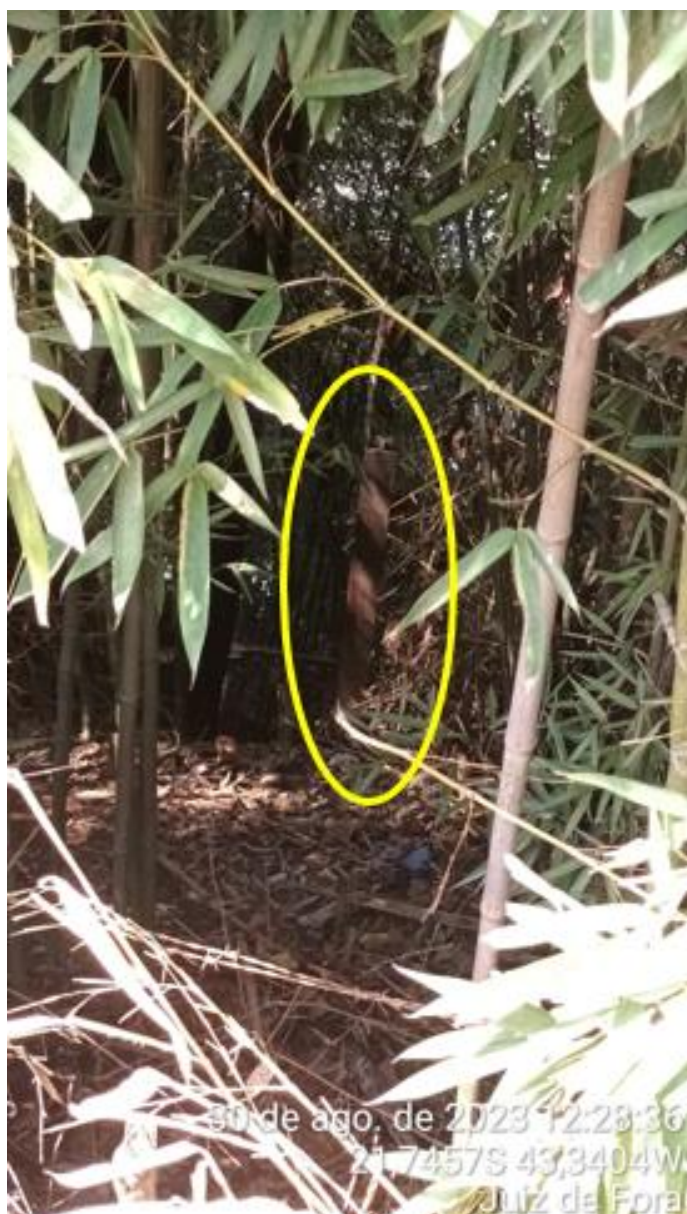
Foto 14 - Trilho metálico cravado (indicado em amarelo) da 2ª linha, mais para dentro do maciço.
