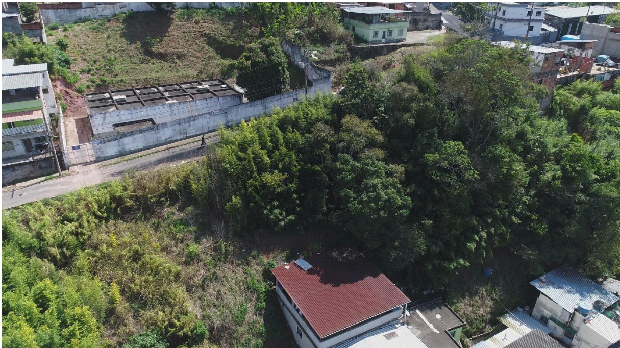
Foto 4 - Vista do reservatório localizado na Antônio Alves Teixeira, com a encosta a jusante da rua.
