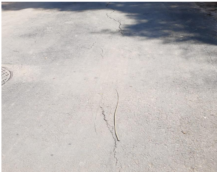
FOTO 3: Trinca no asfalto mostrando início de cunha de deslizamento.
