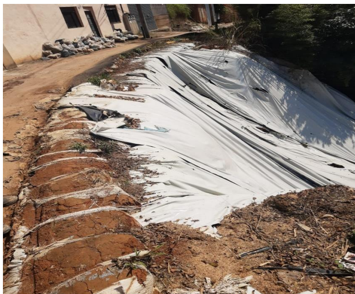
FOTO 2: Leira e lonas colocadas para proteção do talude.
