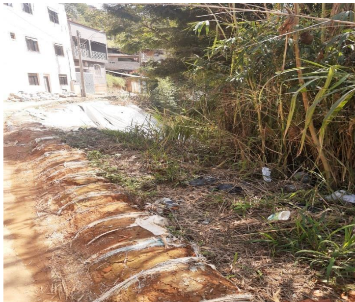
FOTO 1: Evidencia de movimentação de terras no trecho onde se colocou leira de solo cimento ensacado, para proteção do talude, com o direcionamento das águas pluviais para a rua.
