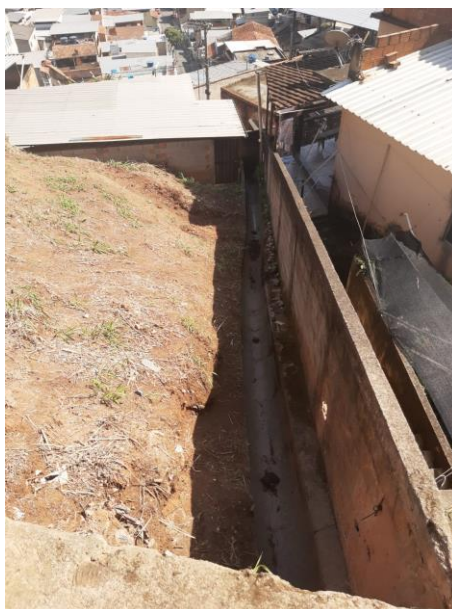
FOTO 3: Lançamento de água pluvial junto ao muro de divisa de casa onde termina a área de intervenção.
