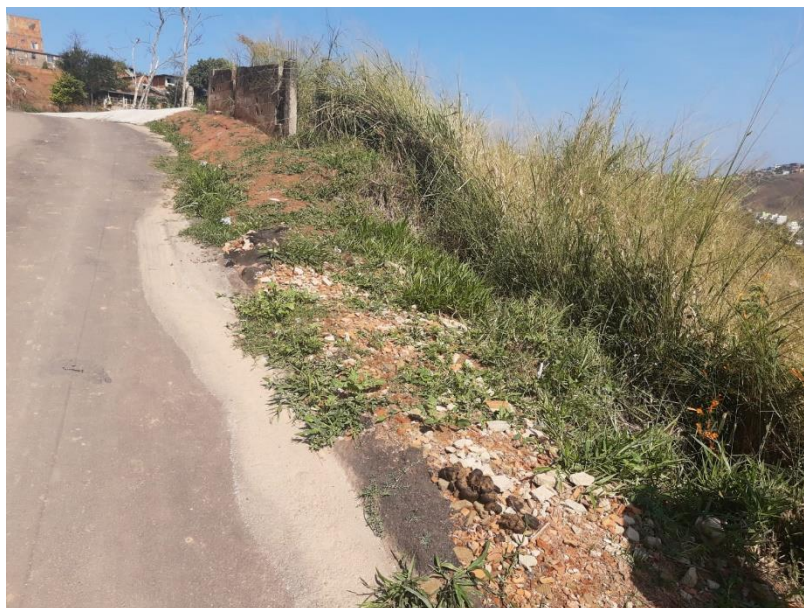
FOTO 2: Leira de solo cimento ensacado para evitar infiltração de água da rua no talude.
