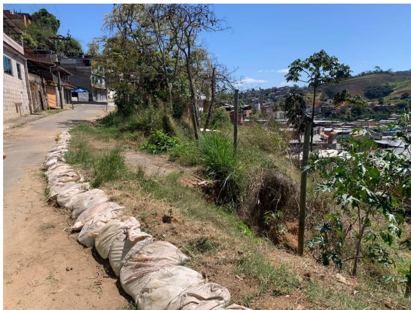
FOTO 3: Trecho a ser projetada a contenção vista da encosta apresentando leira de sacos de solo cimento para proteção das águas pluviais correrem no talude.
