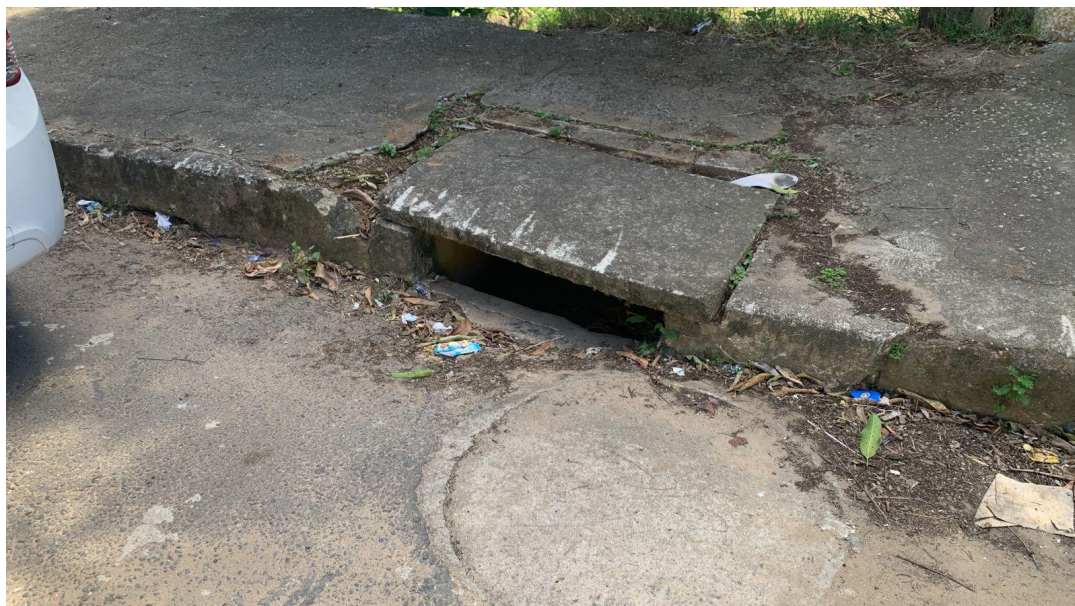
FOTO 4: Boca de lobo existente para coleta de águas pluviais.
