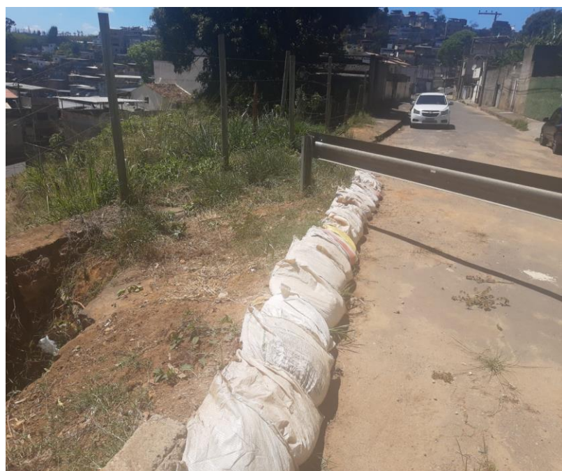
FOTO 5: Mostra a leira de proteção e muro de contenção próximo à rua.
