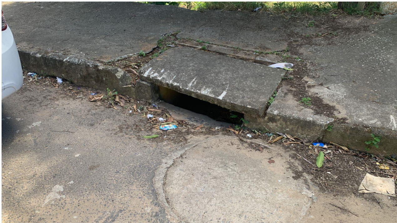
FOTO 6: Boca de lobo próximo a PV de esgoto.
