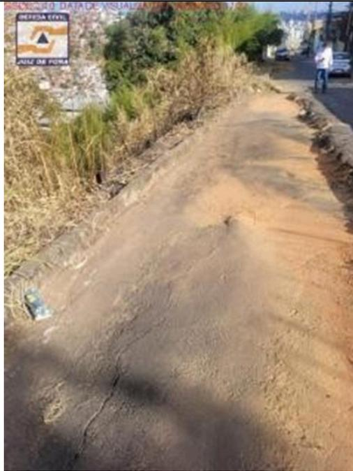
Imagem 1: TRECHO DO LOGRADOURO COM TRINCAS E ABATIMENTO EM FRENTE AO RESERVATÓRIO DA CESAMA, ADJACENTE AO TALUDE (Fonte: Defesa Civil)
