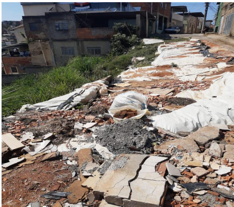
FOTO 2: Leira de solo cimento ensacado para evitar infiltração de água da rua no talude deslizado. Observam-se grande quantidade de entulho.
