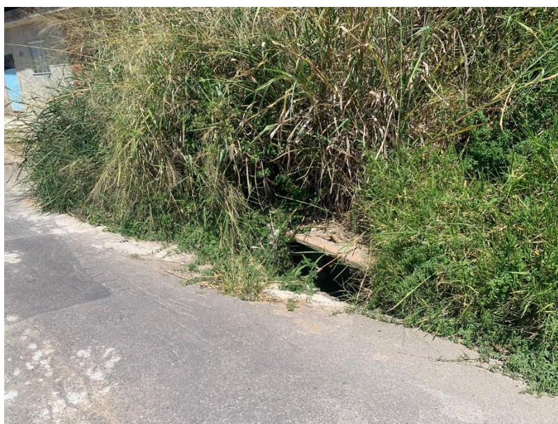
FOTO 5: Mostra de ponto de drenagem , com boca de lobo existente
