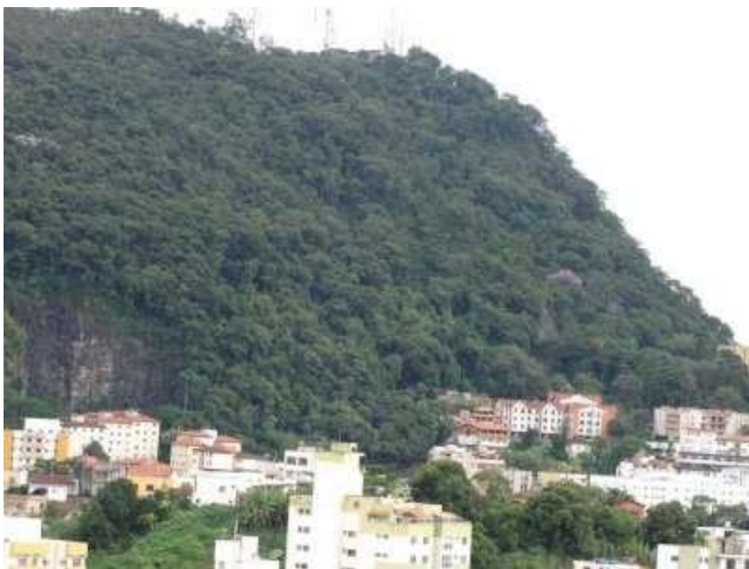
Figura 34: Vista frontal de parte do setor de risco com detalhe para o desnível acentuado, a cobertura vegetal parcial e a ocupação da base do maciço. A presença de cobertura vegetal dificulta a visualização da espessura dos pacotes de solo, bem como a existência de lascas e blocos rochosos instáveis. Autor: Leonardo A. Souza – 2013.
