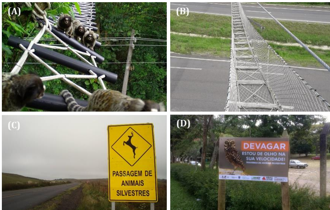
Figura 75: (A) 28 e (B) 29 Exemplos de passarelas suspensas de passagem de fauna sobre estradas e rodovias; (C) 30 e (D) 31 Sinalização educativa alertando sobre a passagem de fauna e redução de velocidade.
