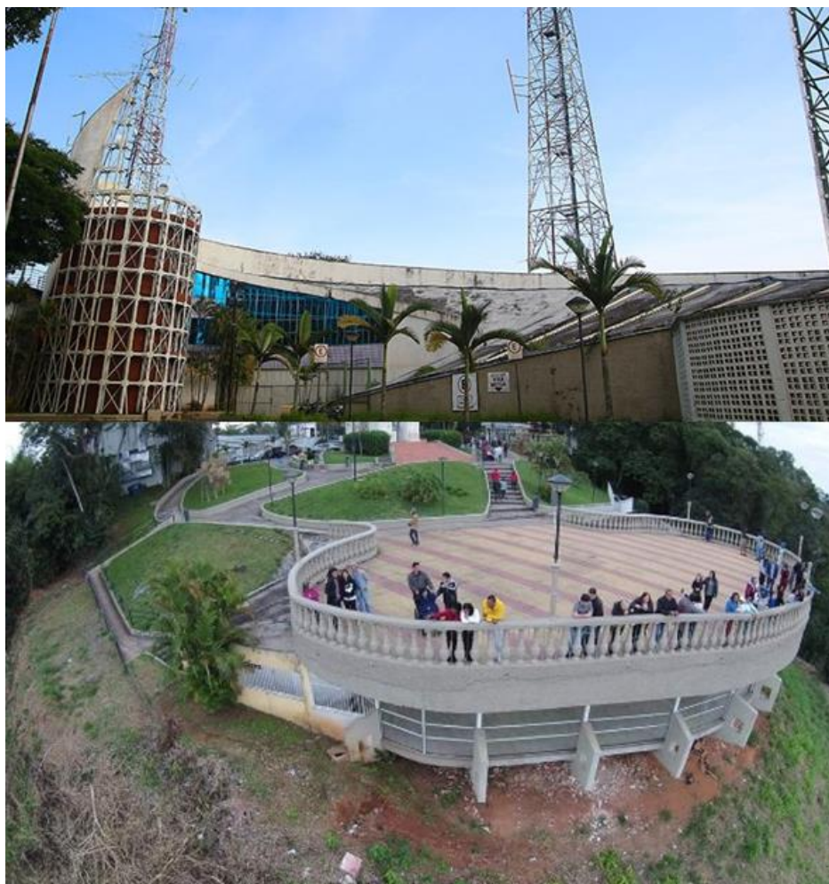
Figura 29: Infraestrutura existente que poderá ser aproveitada para a implementação do Centro de Visitantes do MONAM Morro do Cristo. Edifício sede da antiga TV Industrial (acima) e salão abaixo do mirante (abaixo).
