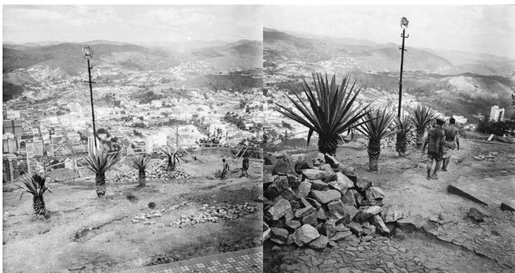
Figura 9: Obras de Construção do Restaurante e Mirante do Cristo na década de 60. Imagem do acervo de Simón Eugénio Sáenz Arévalo 25 .
