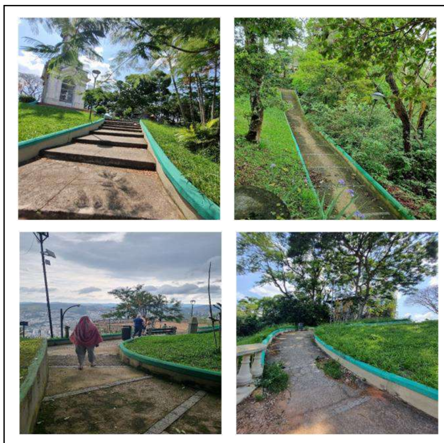
Figura 62: Principais pontos que necessitam de maior aporte para acessibilidade de idosos, pessoas com mobilidade reduzida e deficientes no MONAM Morro do Cristo. Escadas precisam de corrimão de apoio, assim como as rampas de acesso ao mirante, que precisam de manutenção.
