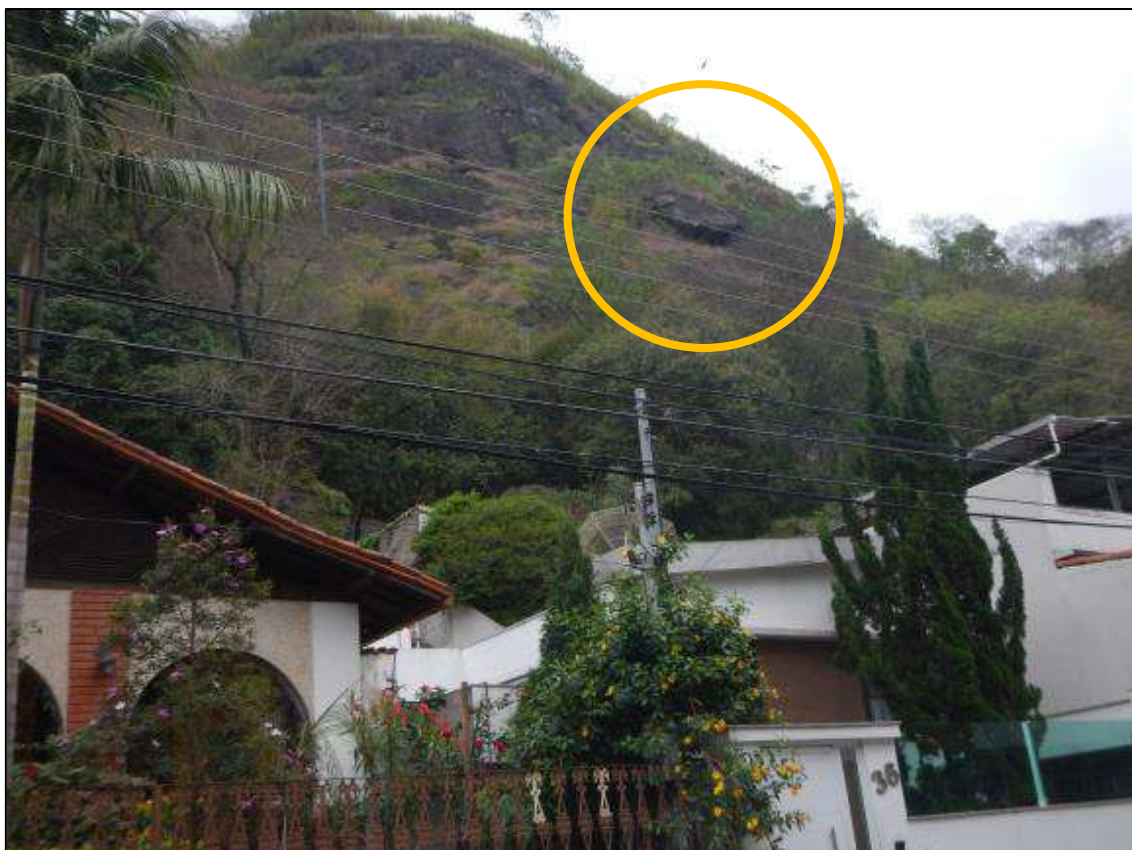
Figura 110: Bloco aparentemente solto identificado muito próximos às residências no sopé do morro do imperador (circundado em laranja). Ocupações vulneráveis a queda de blocos no ponto alto da rua Halfeld. Fonte: Mendonça (2017).
