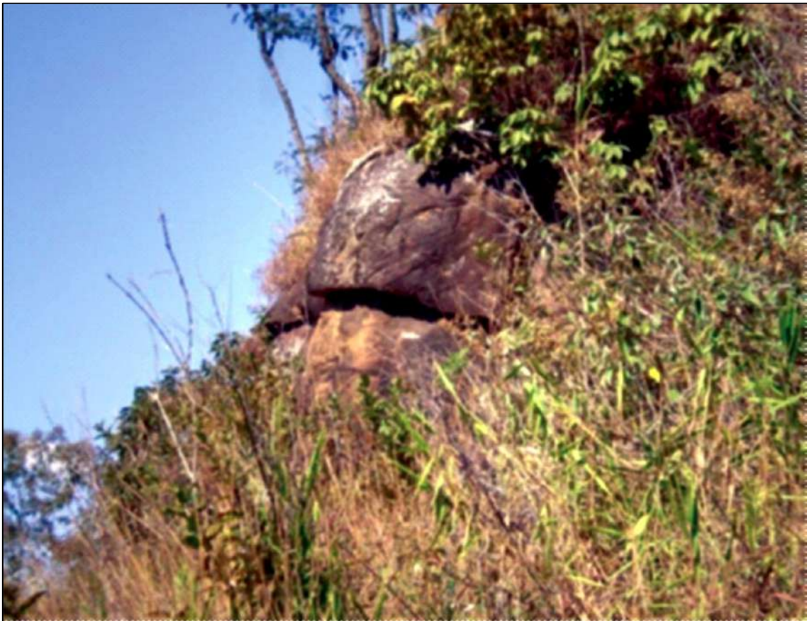
Figura 113: Blocos de rocha evidenciados por fraturas geológicas no Morro do Cristo, Juiz de Fora, MG. Fonte: Rocha et al. (2020).
