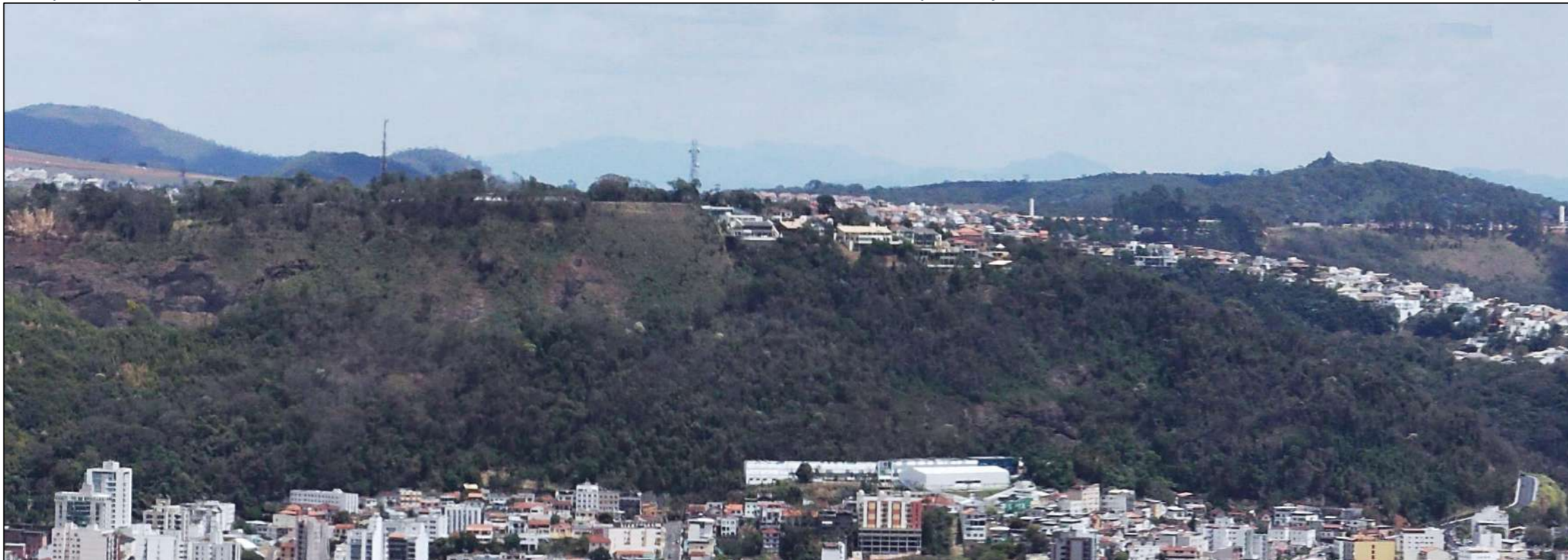
Figura 109: Vertente do MONAM Morro do Cristo referente a área do bairro Parque Imperial, identificado como área de Risco R2 (Risco Médio).
